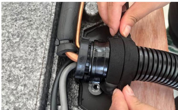
5. Presione el tubo corrugado y la abrazadera contra la bandeja base metálica y atornille los dos tornillos para fijar la abrazadera.
