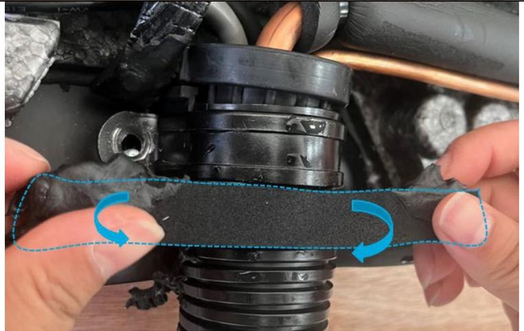
2. Utilice 1 pieza de material de sellado (3) para envolver el tubo corrugado de manera uniforme desde la parte inferior a la superior.
