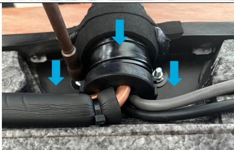
6. Compruebe que la zona quede cubierta por el material de sellado (3) marcado con los triángulos azules.
